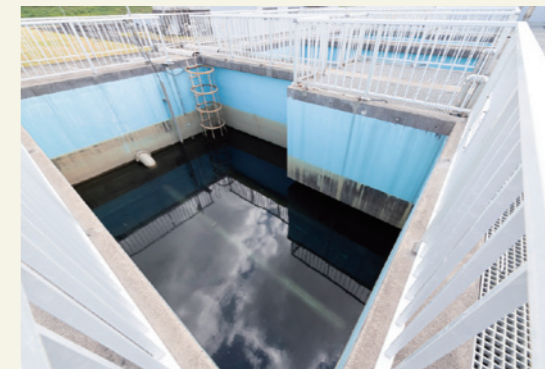
急速ろ過池 沈殿池で取り除けなかった小さな汚れを取り除きます。
