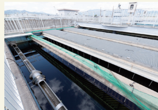
混和池～フロック形成池～沈殿池 凝集剤を混ぜて、水に含まれる小さな砂や汚れを塊（フロック）にします。その後、沈殿池でフロックを沈めて取り除きます。
