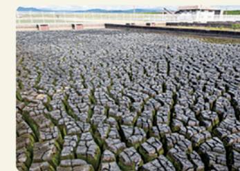
排水池、排泥池、濃縮槽、天日乾燥床
