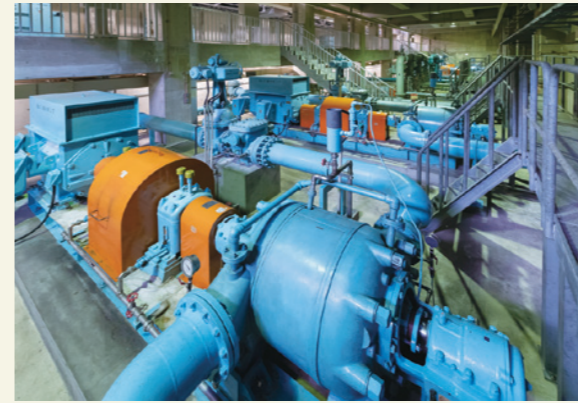
送水ポンプ ろ過した水に消毒用の塩素を混ぜ、水道事業の配水池へ送水します。
