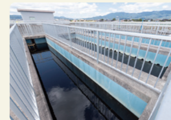
着水井・活性炭接触池、薬品沈殿池、急速ろ過池、浄水池、水質検査施設、管理本館等
